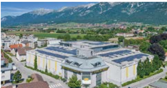
Photovoltaik-Anlage auf der gesamten Dachfläche des Recheis Gebäudes.
